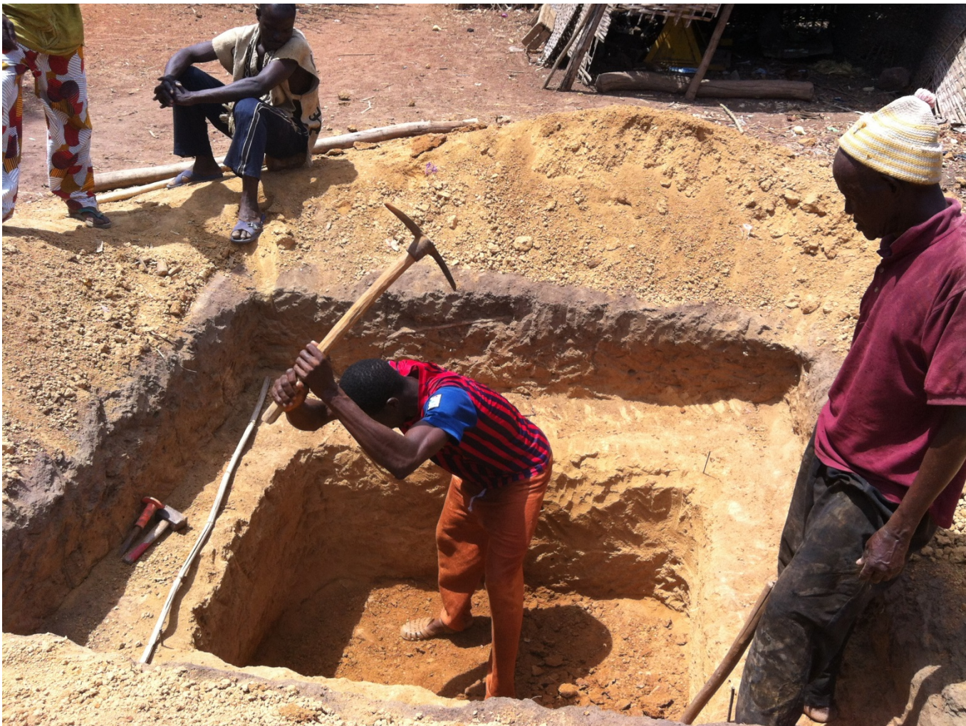
Maçons entrain de creuser une fosse pour des latrines au Sénégal
